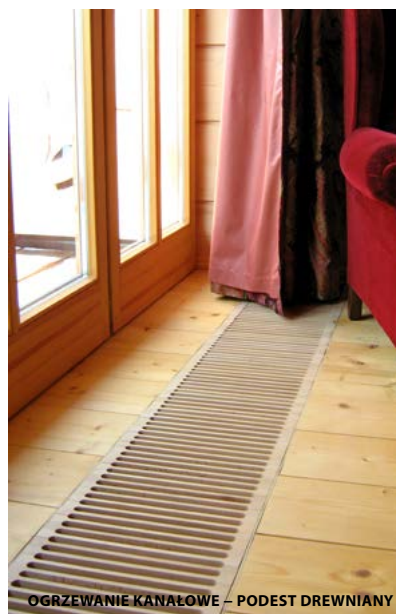
OGRZEWANIE KANAŁOWE – PODEST DREWNIANY
